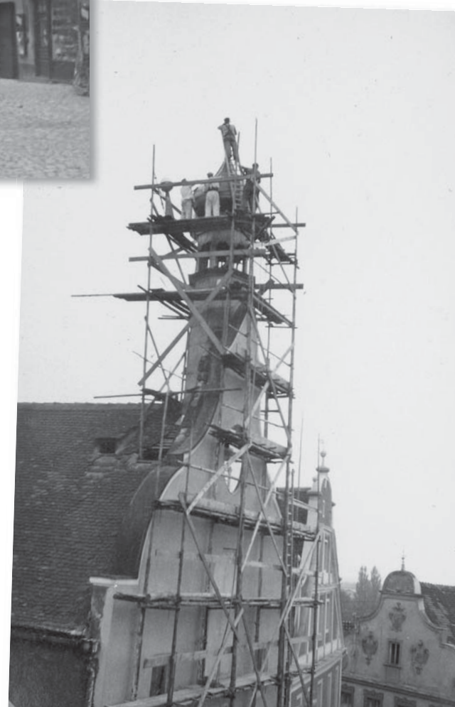
Anfang der 50er Jahre wird das Rathaus saniert.
