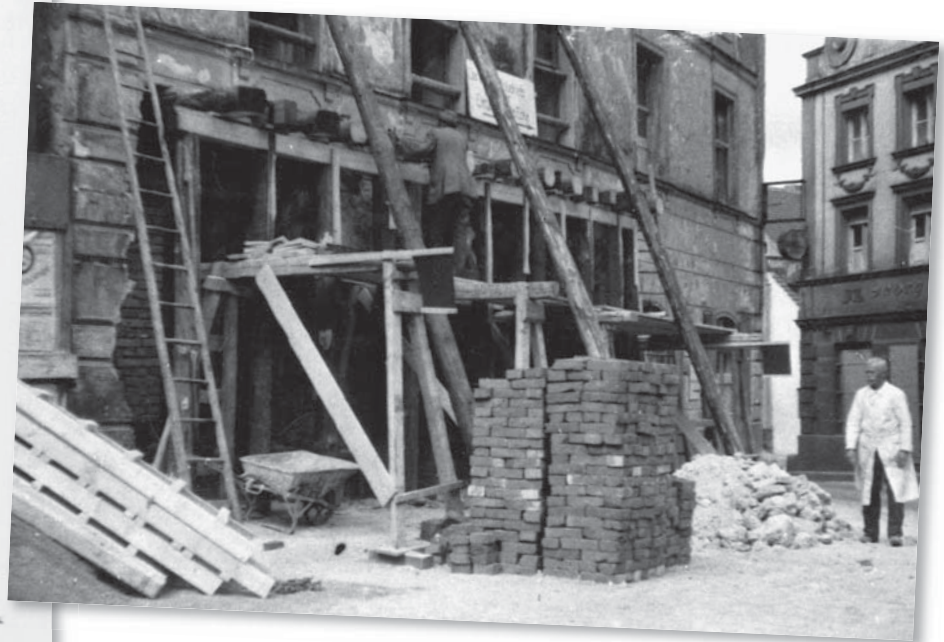
Auch der Eingangsbereich wurde vergrößert.
