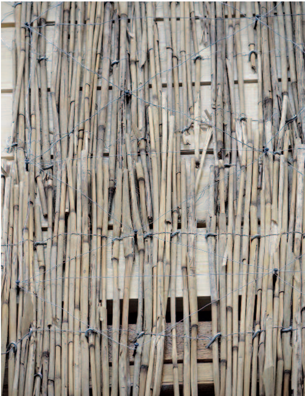
3 Detail Schilfrohrarmierung
