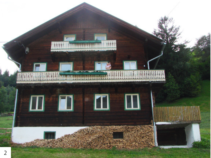
2 Das Wohngebäude kurz nach unserem Einzug.
