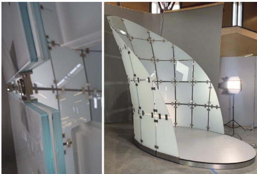
**Bild 4** Detailausschnitt und Gesamtansicht der Glasschale (© knippershelbig GmbH)
